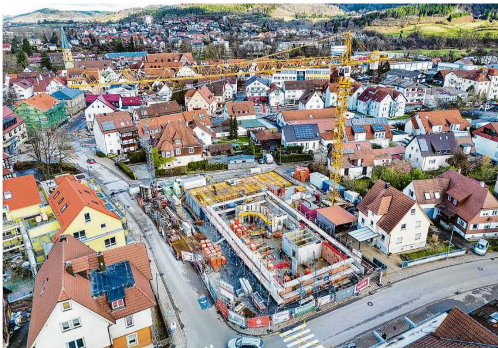
Die Bauarbeiten am neuen Regionalcenter in Gaildorf liegen gut im Zeit- und Kostenplan. 2025 soll es eröffnet werden.
